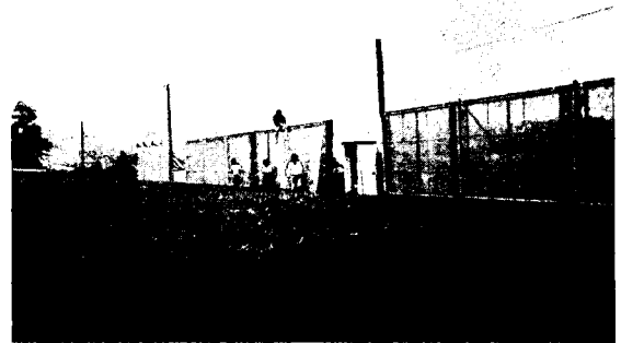
静電式ネットの設置状況
